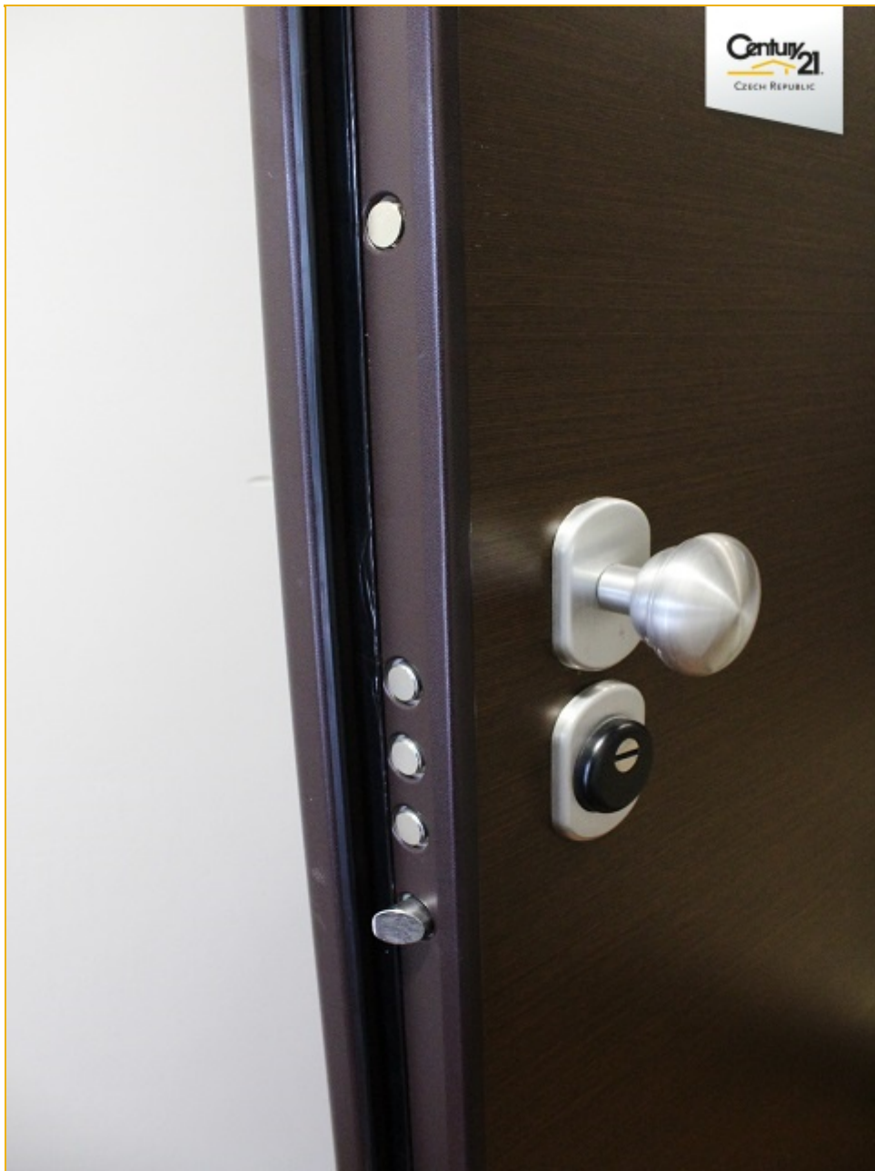
vchodové dveře do bytu
